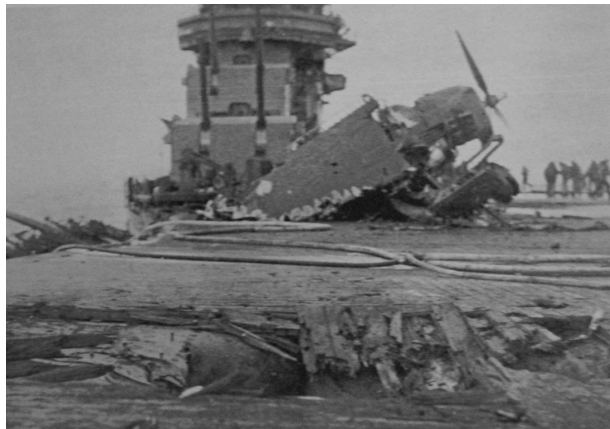
La partie avant du pont fortement endommagé le 21 février 1945.
