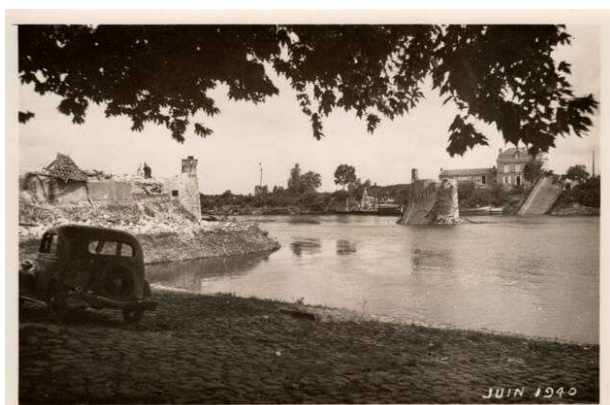
Le pont de Chalonnes après sa destruction (source : Ouest France, article du 5 juin 2020).
