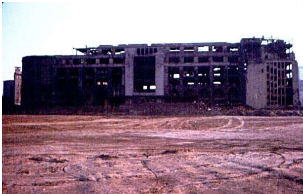
Les travaux préparatoires à la destruction.
