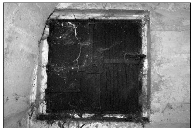
La sortie de secours de l'abri anti-aérien.
