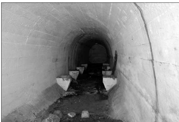
Vue de la galerie sud-est de l'abri anti-aérien.
