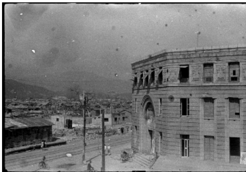
Dans le quartier de Main Street, la succursale de la banque du Japon. Située à 380 mètres de l'explosion, ce bâtiment a résisté à la déflagration ; la banque a rouvert ses portes deux jours après.
