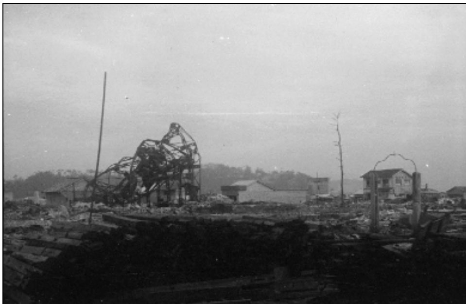
Hiroshima, les structures métalliques ont été tordues par la chaleur de la déflagration.
