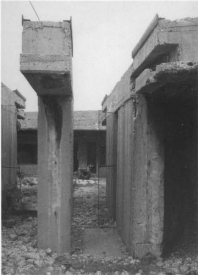
Auf dem G-Turm Augarten. Links: die Schneise für die Ruhestellung 0 der 12,8 cm Zwillings-Flak. Rechts: die Aussparung in der oberen Plattform für den Kran in Ruhestellung.
