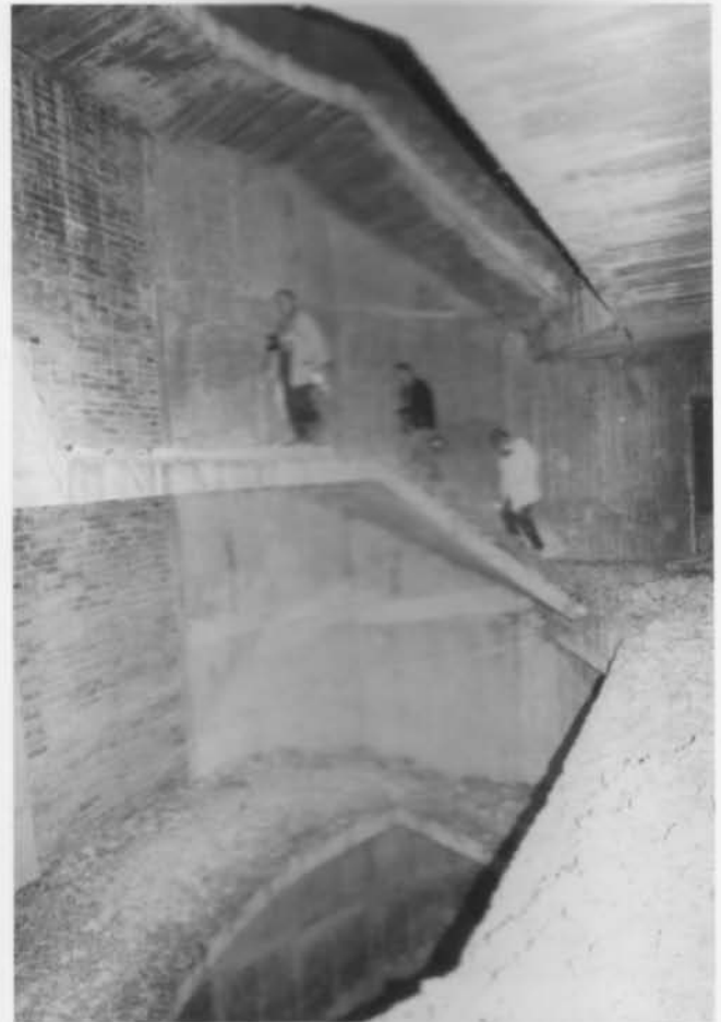
Gut sichtbar die Zerstörungen durch die Sprengung der Sowjets im G-Turm Augarten. Riesige Eisenbetonblöcke sind aus den Wänden des Innenbereiches herausgerissen worden. Rechts: die Größenordnung wird deutlich. Besetzt wird der G-Turm durch Tauben, die durch die Öffnungen in der Außenwand in das Innere gelangen.
