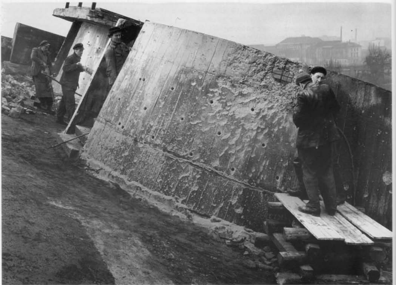
Vorbereitungen am 22.11.1952 zur Sprengung des L-Turms Zoo. Sprenglöcher werden in den Schutzsockel des E-Meßgeräts gebohrt.
