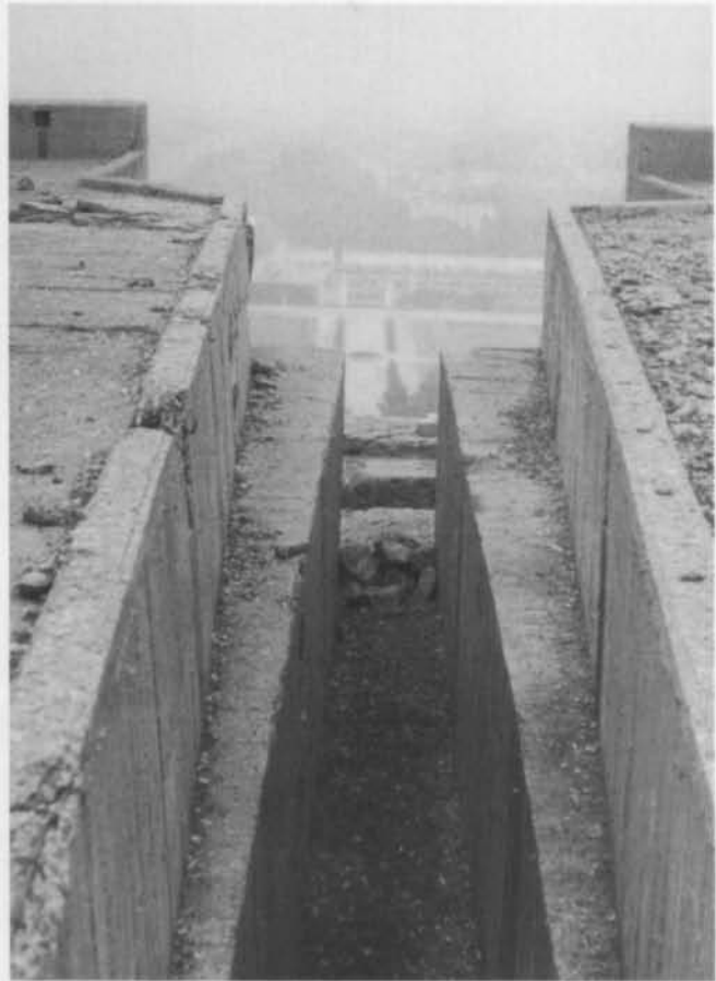
Auf dem G-Turm Augarten. Links: die Schneise für die Ruhestellung 0 der 12,8 cm Zwillings-Flak. Rechts: die Aussparung in der oberen Plattform für den Kran in Ruhestellung.
