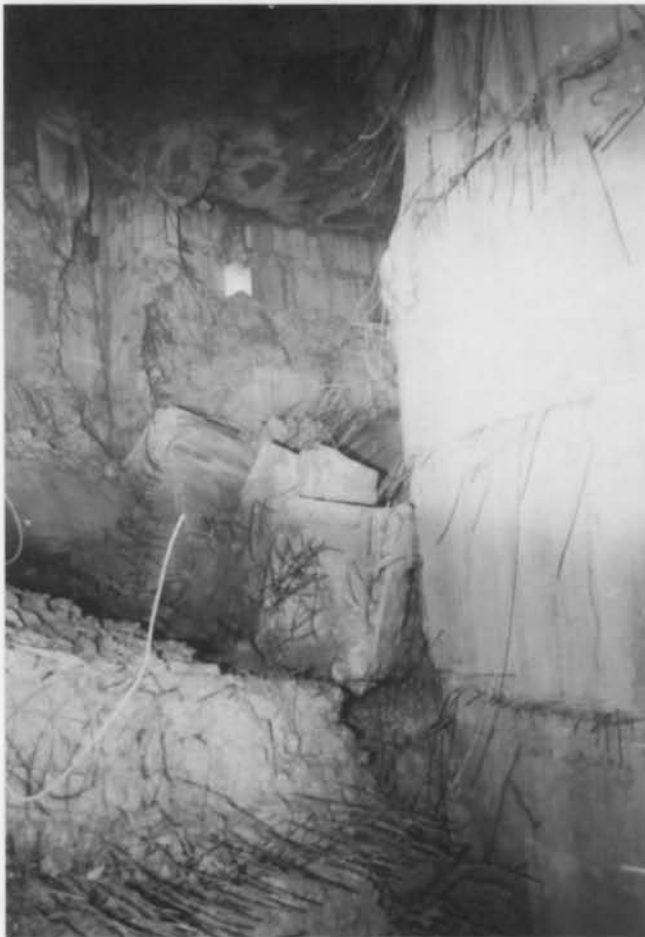
Gut sichtbar die Zerstörungen durch die Sprengung der Sowjets im G-Turm Augarten. Riesige Eisenbetonblöcke sind aus den Wänden des Innenbereiches herausgerissen worden. Rechts: die Größenordnung wird deutlich. Besetzt wird der G-Turm durch Tauben, die durch die Öffnungen in der Außenwand in das Innere gelangen.
